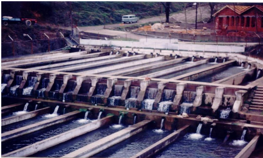
Εικόνα 32. Δρόμοι από σκυρόδεμα για καλλιέργεια γόνων
